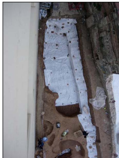
FOTO 31. Àrea sud. Vista general de la banda nord de la intervenció, amb la protecció amb geotèxtil on era necessari
