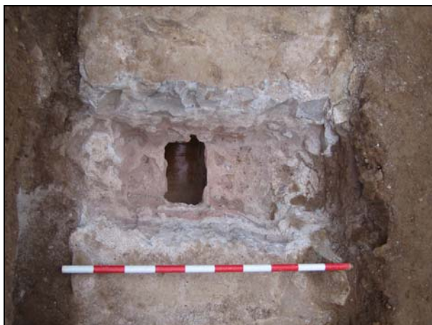
FOTO 10 Detall de l'interior de la canonada (UE 138) on es pot observar el conducte ceràmic, amb l'interior vidrat de color marró. A la imatge es pot observar l'amplada de l'estructura, d'1m
